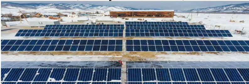
Автономная СЭС, 320 кВт, с. Менза, Забайкальский край, январь 2017.
